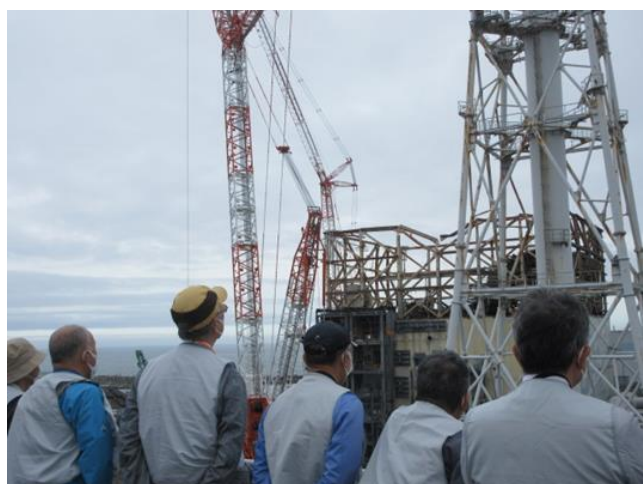
1号機の建屋の撤去作業を見学
